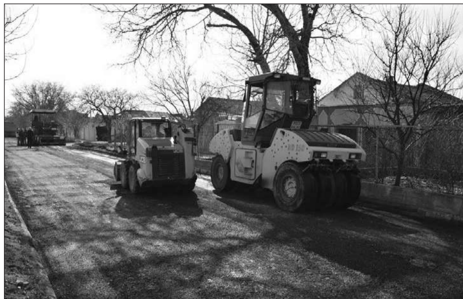
Ремонт дороги на улице Средней
