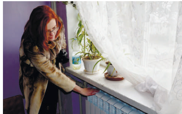
Общежития на улице Крупской подключили к центральному отоплению
